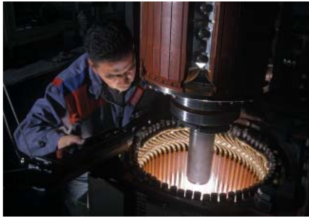
Slika 3. Spuštanje rotora u stator
