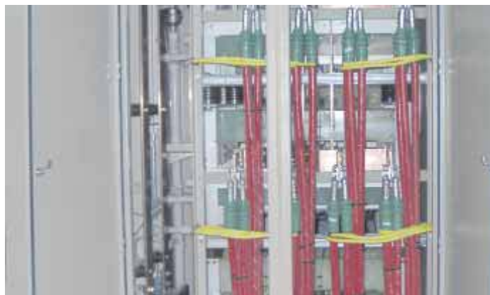
Slika 3.5.3 Linijski ispravljači
