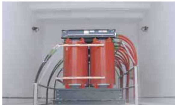
Slika 3.5.6 Izlazni trafo
