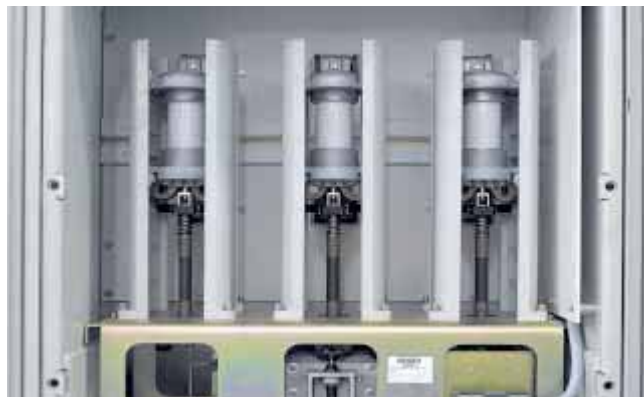
Slika 3.5.8 Linijski prekidači
